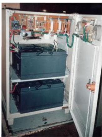
В отличие от распространённых и агрегатов бесперебойного питания (АБП, ИБП, UPS) имеющих вход и выход переменного напряжения, СГЭ имеют вход от сети переменного напряжения, а выход - постоянного напряжения. Отсутствие инвертора значительно удешевляет систему, но ограничивает её применение только для определённых приборов, работающих от постоянного напряжения.
